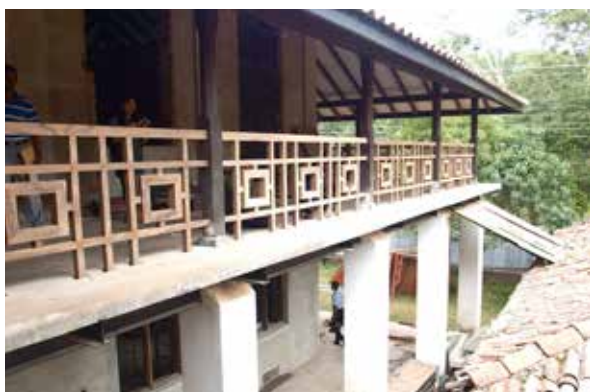
写真 128. 改修中建物の外観
