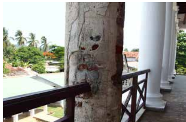
写真 13. 2階柱廊 (修復前の柱を一部残している)
