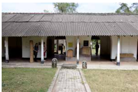
写真 131. 建物脇の収蔵庫
