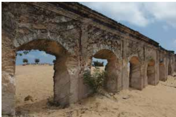
写真 62. 聖アントニウス教会身廊部分
