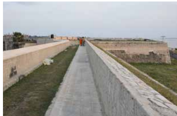
写真 50. 修復済みのフォート外壁上部
