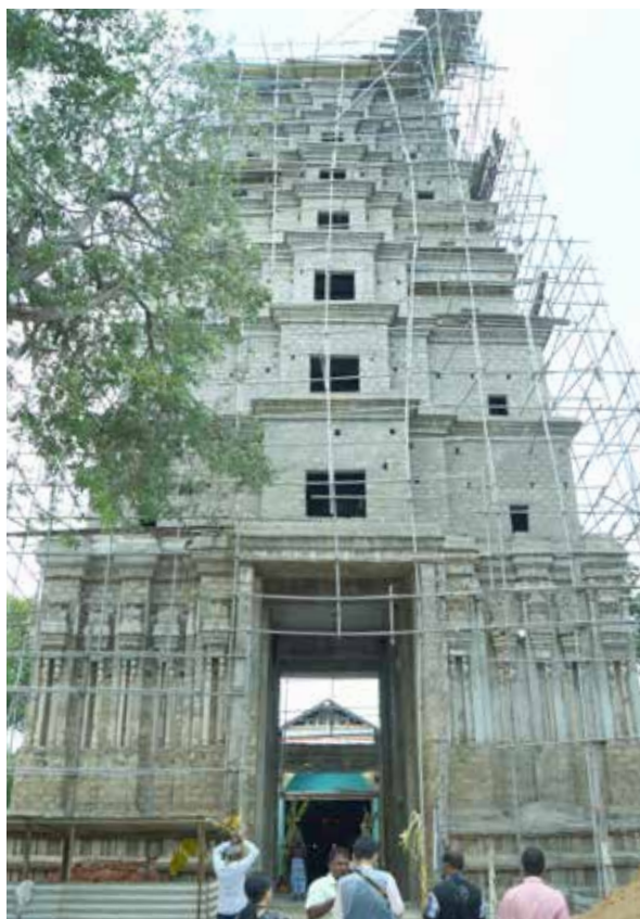
写真 71. 再建中の寺院
