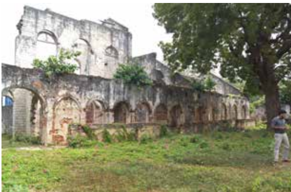
写真 20. 銃痕の残る壁面
