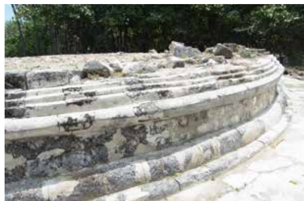
写真 76. ストウーパ基礎部分の拡大
