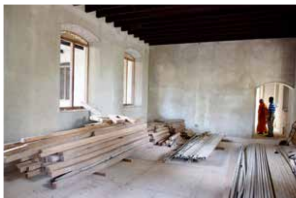
写真 129. 改修中建物の内観
